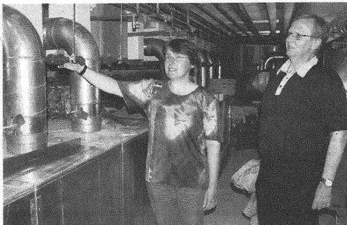
**Reinbek. Branka Trube erläutert Bürgermeister Axel Barendorf, wie in Zukunft das Kondenswasser aus den modernen Lüftungskanälen für die Schwimmhalle geordnet entsorgt wird.**
