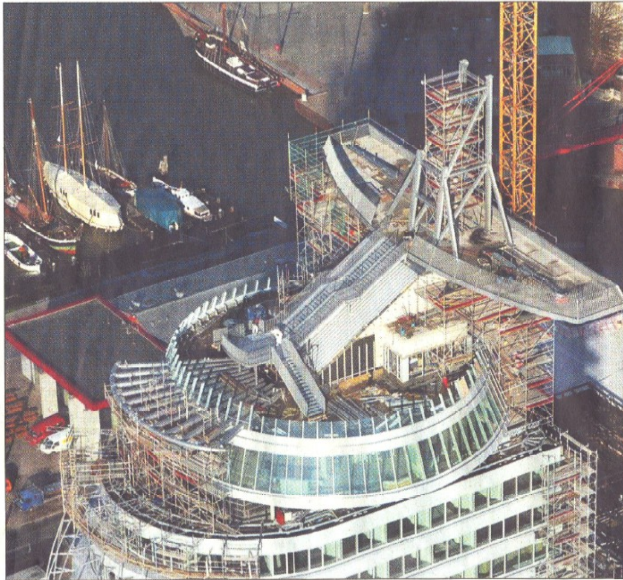
Auf dem Sail-City-Hotel wird in luftiger Höhe der Mast gesetzt.
