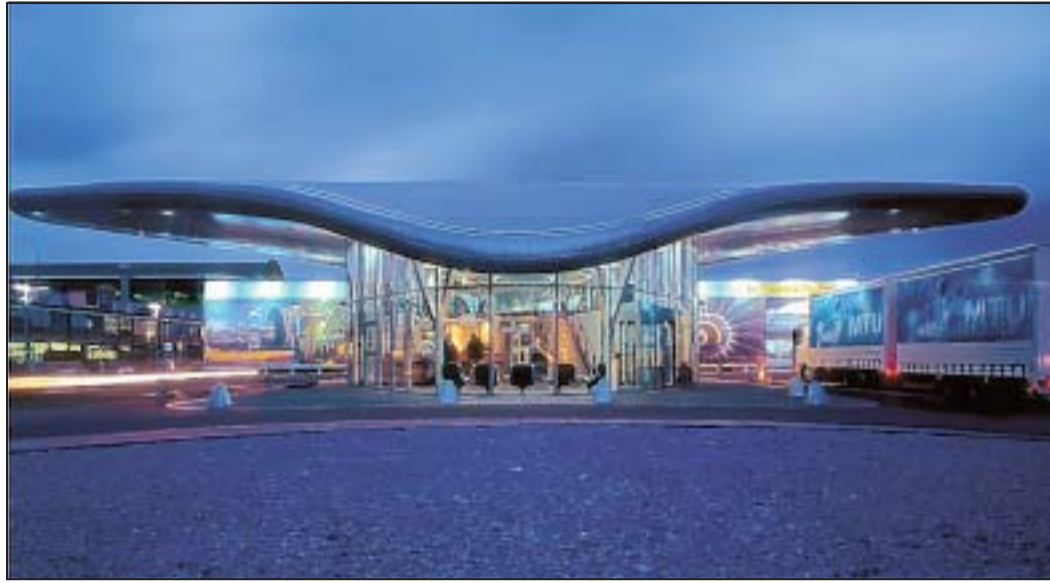
Das Stahlgerüst des Empfangsgebäudes der Lufthansa Technik AG, das am Hamburger Flughafen steht, wurde an der Glinder Humboldtstraße von Buthmann gebaut.
